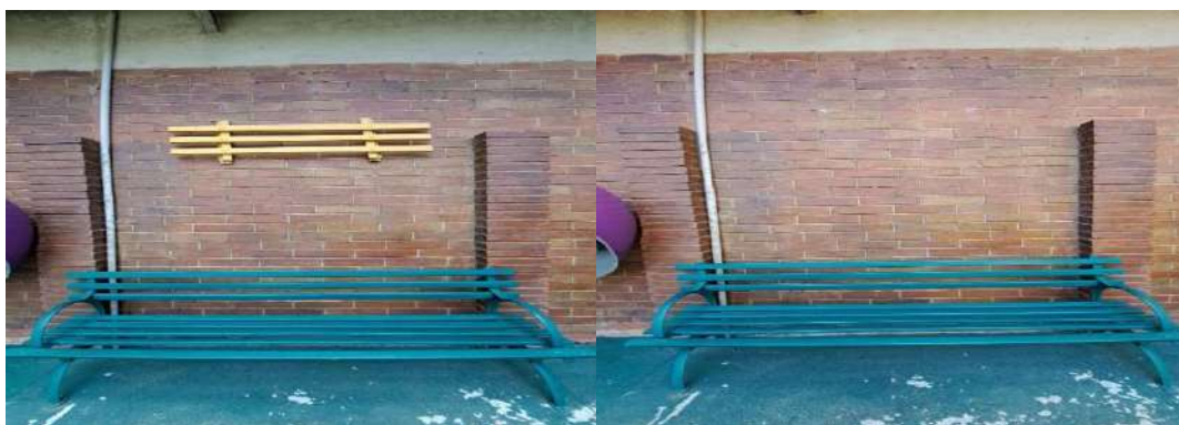
Figura 17: Recolocação de placas
